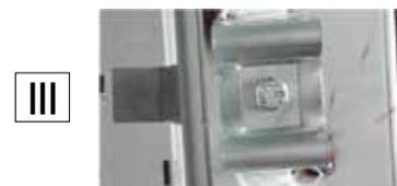
Solo dopo il controllo preventivo delle misure, procedere alla posa del falsotelaio (a cura del cliente), che deve avvenire senza togliere i distanziali saldati al falsotelaio e per mezzo delle zanche a cementare, avvitando le stesse tramite le viti M8x30 con testa esagonale con una chiave fissa o a tubo da 13, utilizzando i fori Ø 10 mm predisposti sui montanti del falsotelaio in prossimità dei cavallotti (fig. III).
